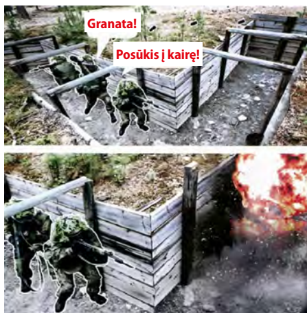
27 pav. Tranšėjų įrengimas laužytos linijos būdu – zigzagu
